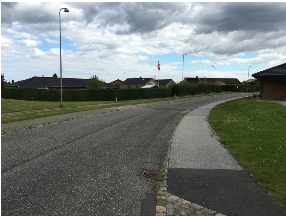
Billede 3 Sigten for fodgængere, som ønsker at krydse Gaiavej ved Gaiahuset, er lidt under den anbefalede grundet huset i kurven.
