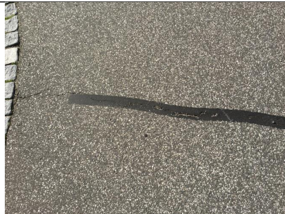
foto 9 Revne i asfalten, som er forsegleet men det har mistet sin virkning
