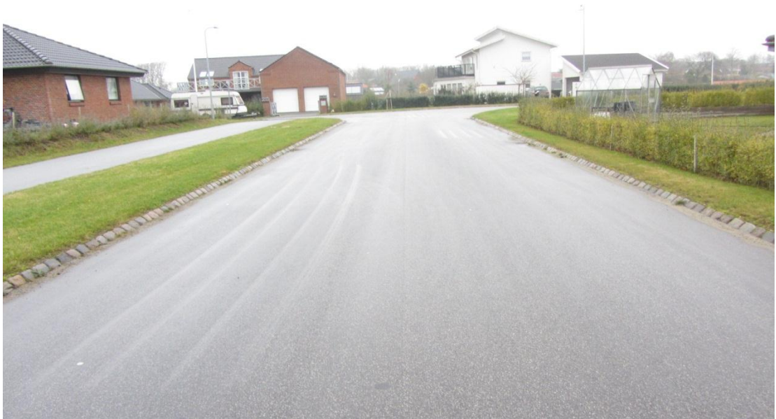
Billede 2 Spor efter tromlens hjul på Adonisvej – stamvejen
