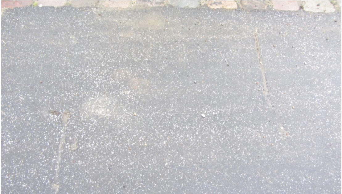
Billede 9 Indtryksmærker fra henstilling af ting på kørebanen
