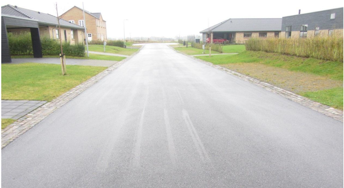
Billede 1 Spor efter tromlens hjul på Adonisvej 14-24
