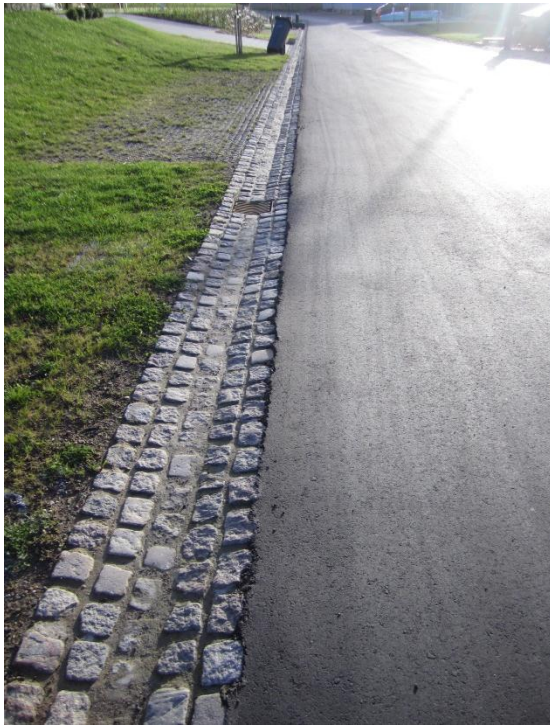
Billede 7 Slidlag ligger højt i forhold til trug
