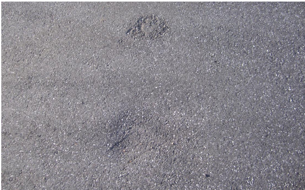
Billede 3 Vridninger i belægningen på Adonisvej 79-87
