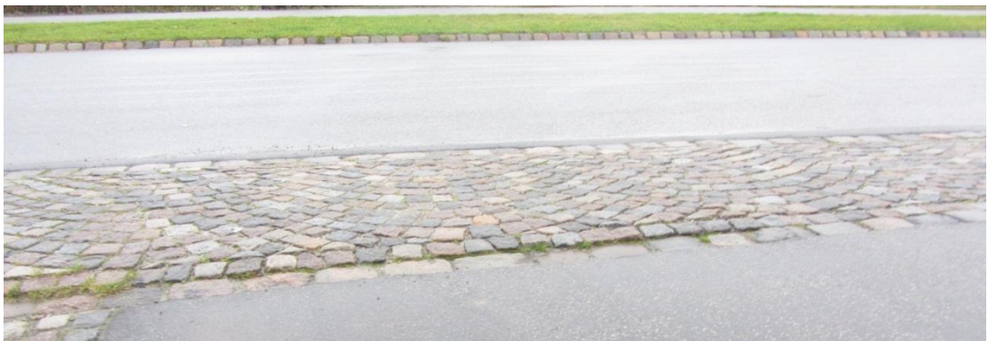
Billede 8 Chaussésteno ligger højt i forhold til brostensbånd ved overkørsel på Adonisvej 45-59
